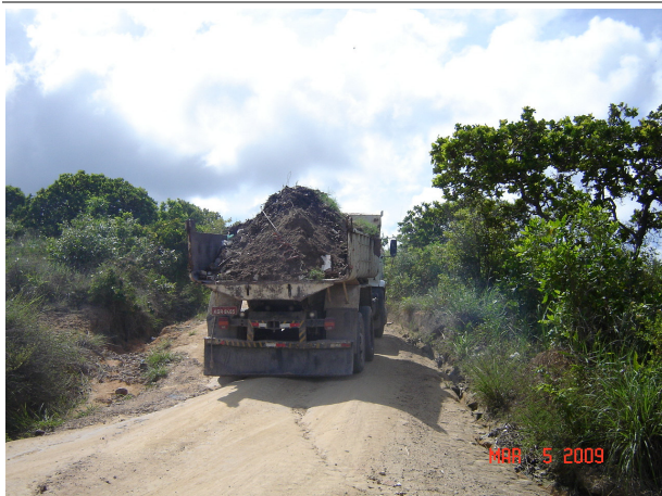
Foto 34 - Caminhão caçamba Fonte: Consórcio Techne-Geosistemas – Mar/2009
