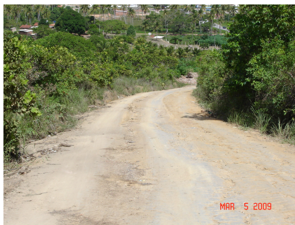
Foto 39 - Acesso ao lixão Fonte: Consórcio Techne-Geosistemas – Mar/2009
