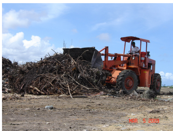
Foto 36 - Retro-escavadeira em operação no lixão Fonte: Consórcio Techne-Geosistemas – Mar/2009
