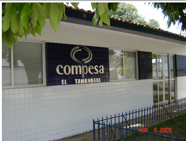
Foto 6 - Escritório local da COMPESA Fonte: Consórcio Techne-Geosistemas – Mar/2009
